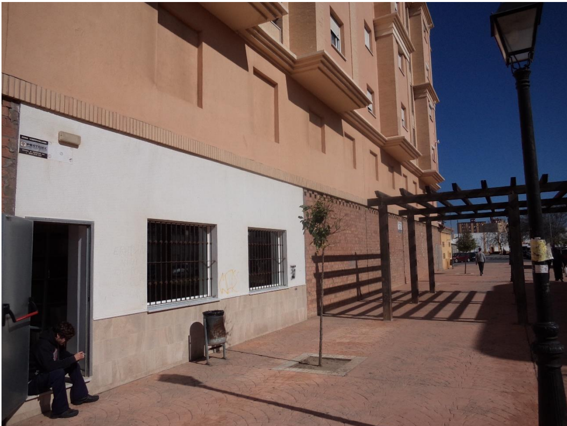
Fachada Paseo Velada.
