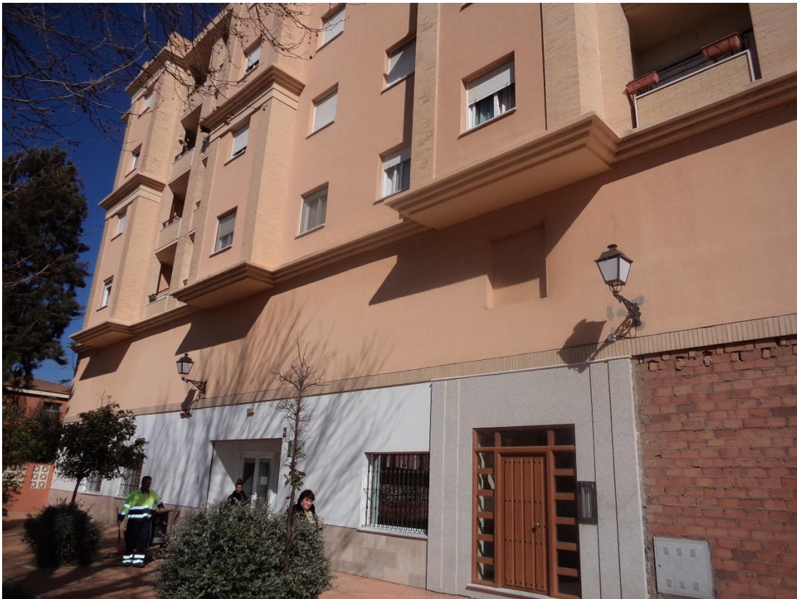
Fachada Paseo Velada
