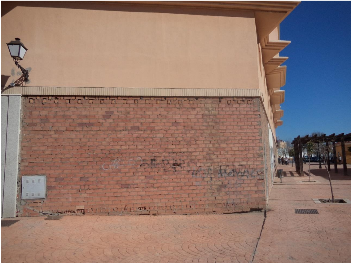
Fachada Paseo Velada
