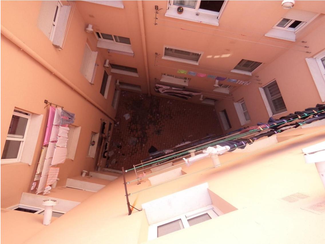
Estado original patio interior
