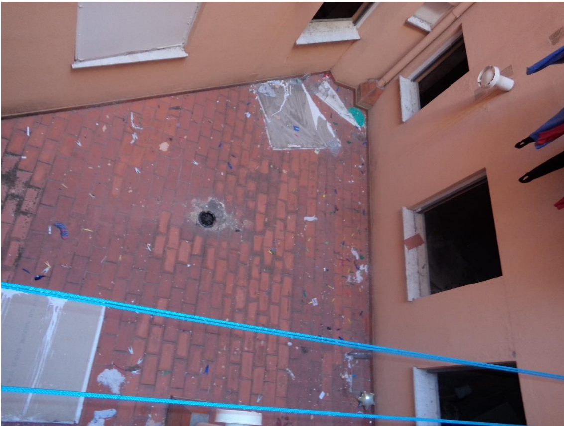
Estado original patio interior
